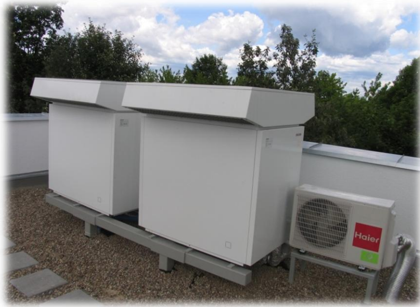
Rys. 58. Powietrzne pompy ciepła Autor: Bartłomiej Asztemborski
