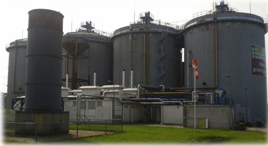
Rys. 21. Komory fermentacyjne biogazowni Autor: Dariusz Koc
