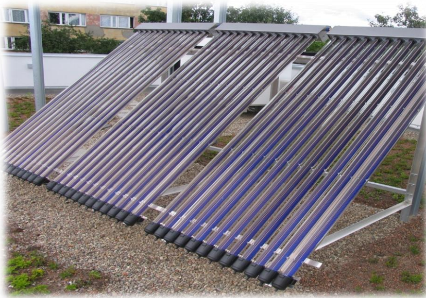
Rys. 31. Kolektory próżniowe Autor: Ryszard Wnuk
